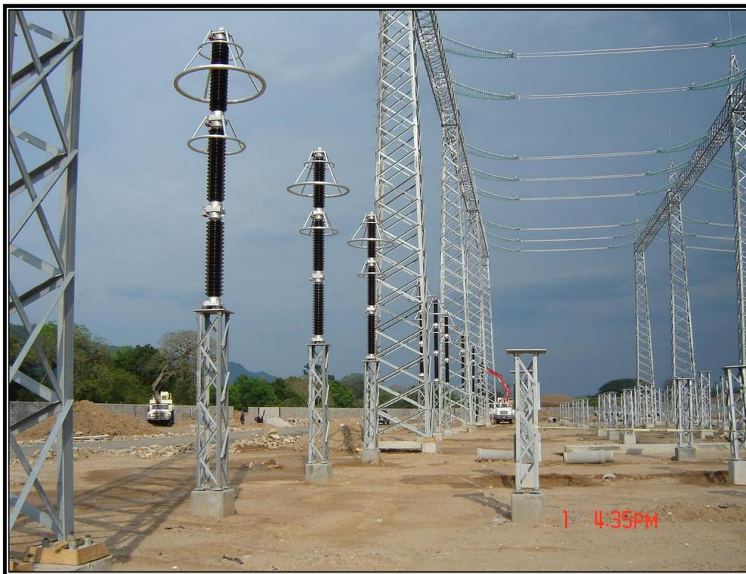
FIGURA 1.86 Proceso de Montaje y Conexión de Apartarrayos.
