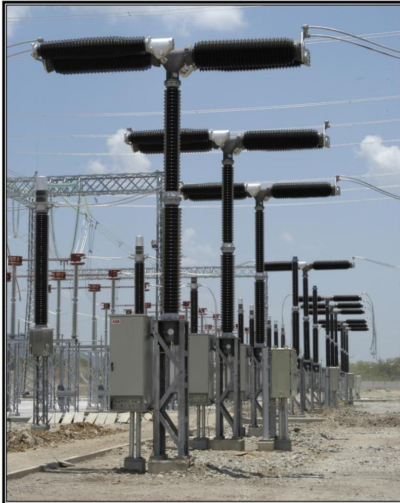
FIGURA 1.36 Interruptor de Potencia con Cámara de Corte.
