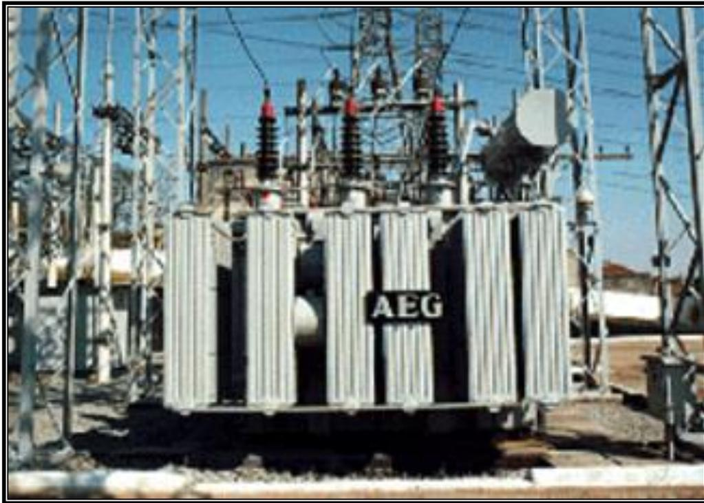
**FIGURA 1.13** Subestación Eléctrica Receptora Secundaria.
