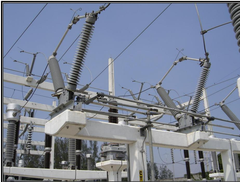
FIGURA 1.67 Cuchilla Desconectadora Tipo V.
