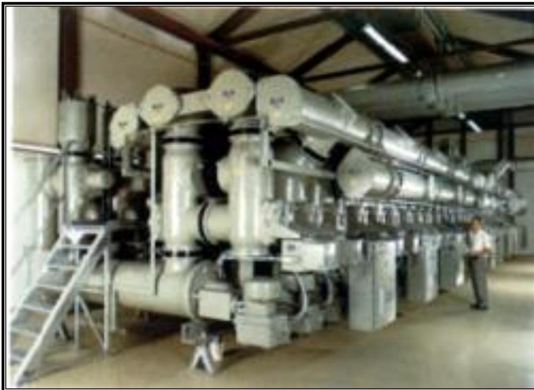
**FIGURA 1.10** Subestación Eléctrica en Hexafluoruro de Azufre (SF<sub>6</sub>).
