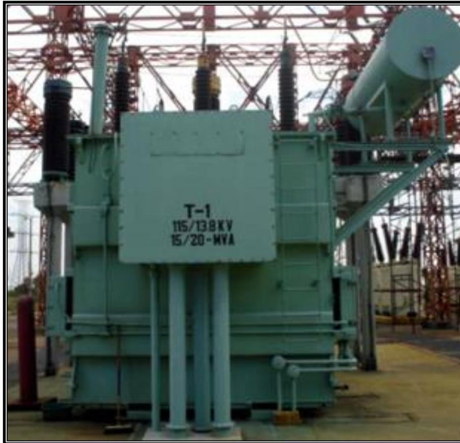
**FIGURA 1.15** Transformador de Potencia 115/13.9 KV de 15/ 20 MVA.
