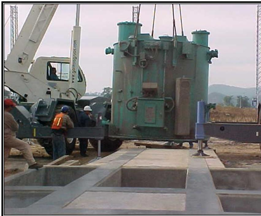
FIGURA 1.30 Maniobra para Puesta del Transformador.
