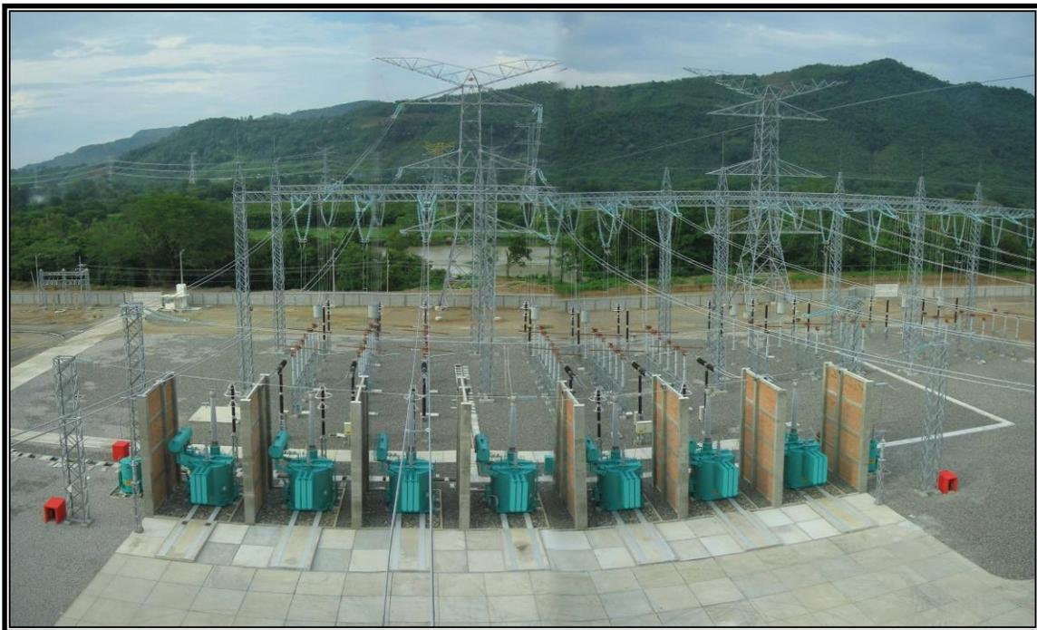
FIGURA 1.14 Banco de Transformadores de la Subestación Las Mesas.
