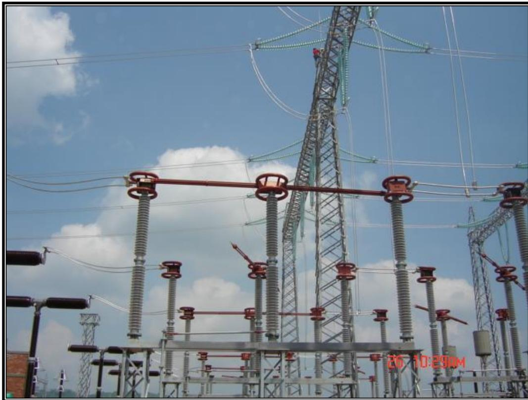
FIGURA 1.62 Cuchillas Desconectoras en Aire de Operación en Grupo Tipo "DAL" (Doble Apertura Lateral).
