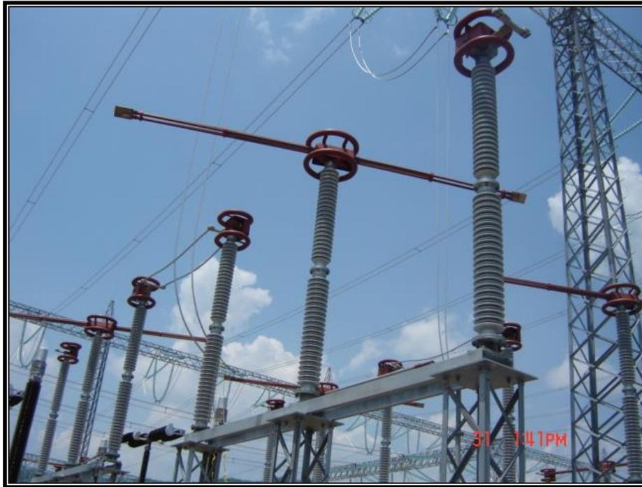
FIGURA 1.66 Cuchillas Desconectadora Tipo DAL.
