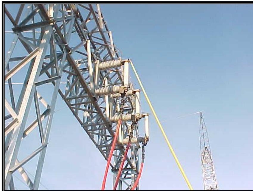
**FIGURA 1.63** Corta Circuitos de Potencia.
