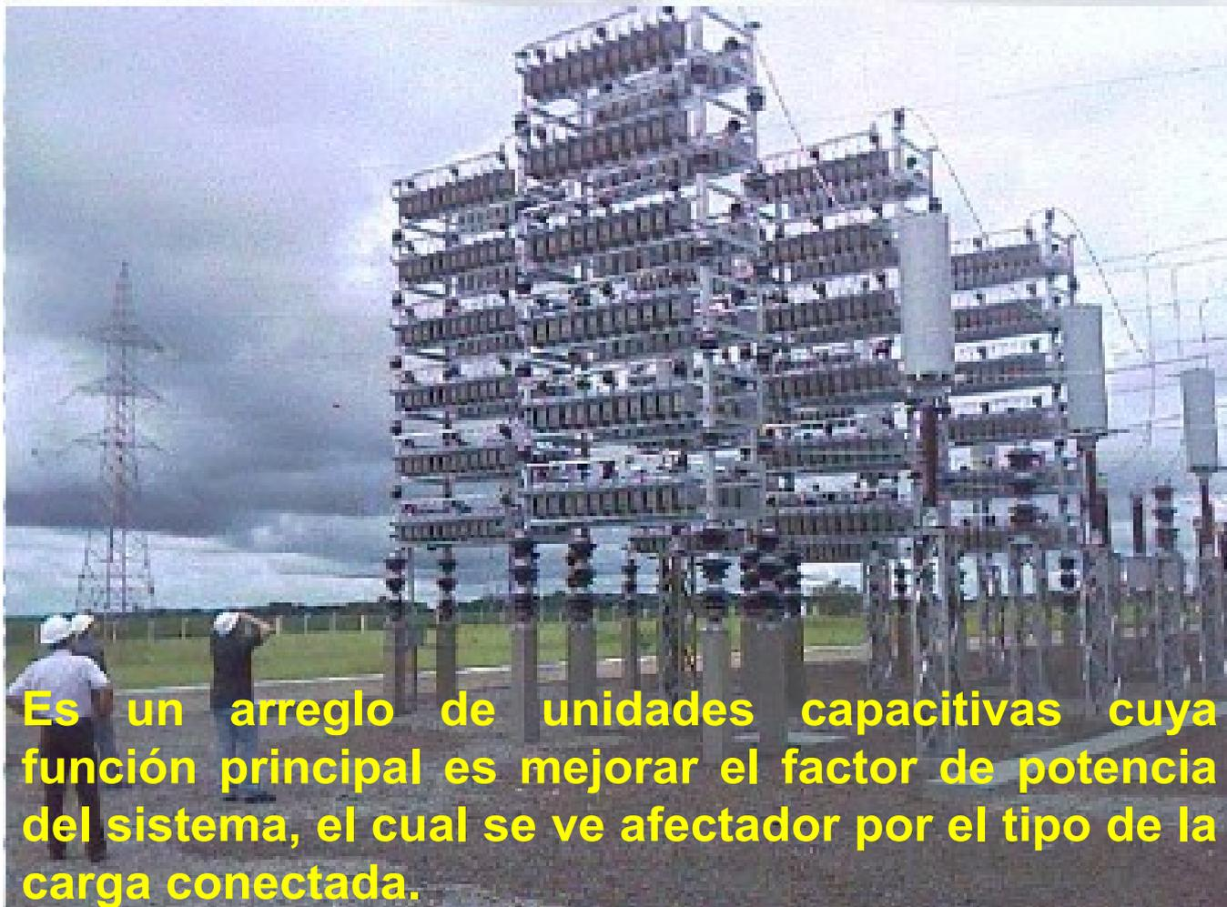
**Es un arreglo de unidades capacitivas cuya función principal es mejorar el factor de potencia del sistema, el cual se ve afectador por el tipo de la carga conectada.**
