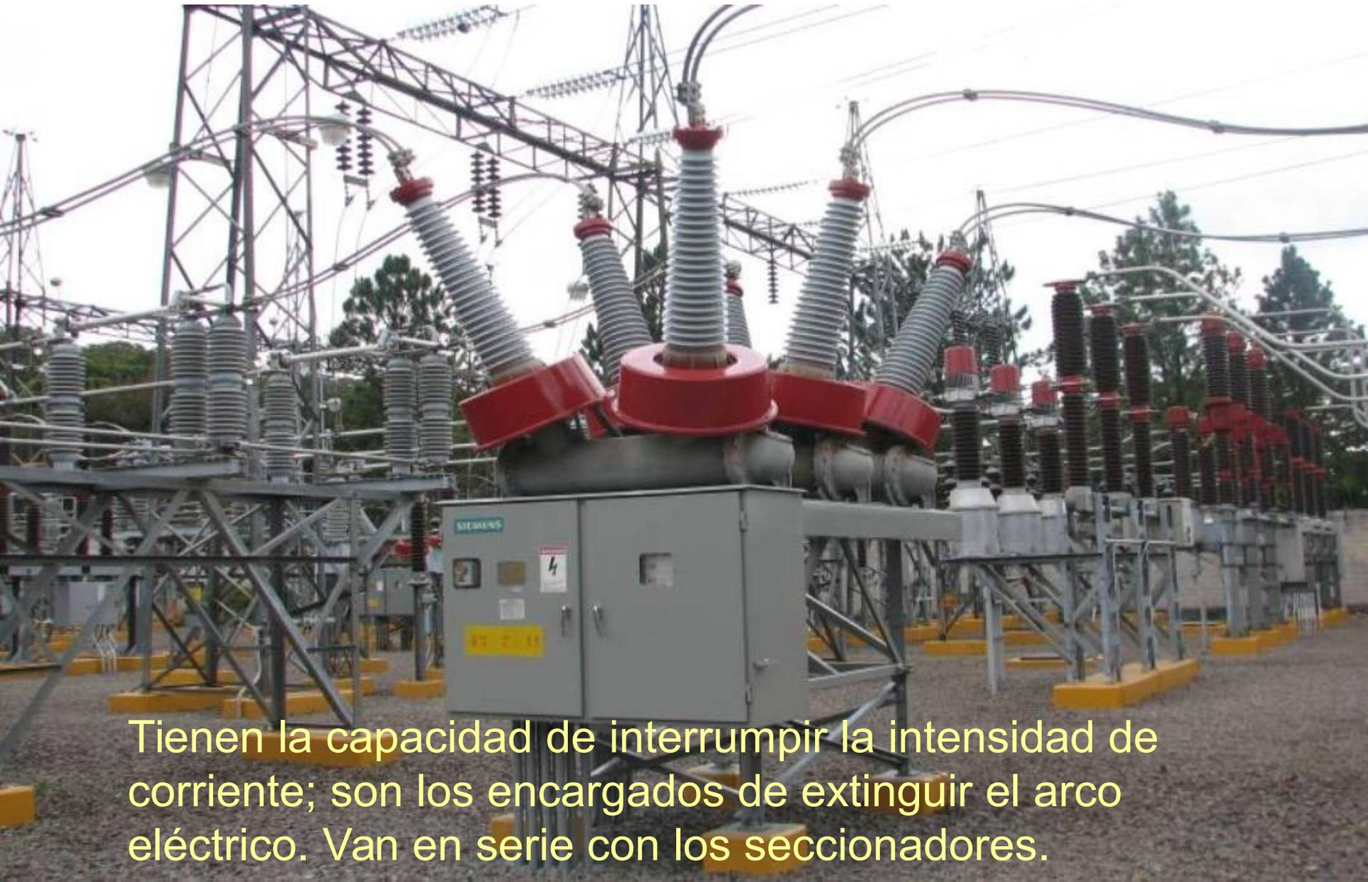
Tienen la capacidad de interrumpir la intensidad de corriente; son los encargados de extinguir el arco eléctrico. Van en serie con los seccionadores.
