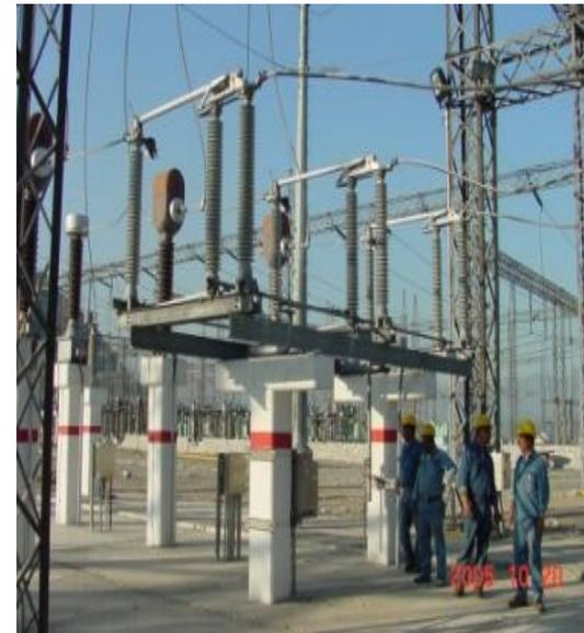
CUCHILLA TIPO APERTURA VERTICAL, MONTAJE HORIZONTAL DE 115 KV.
