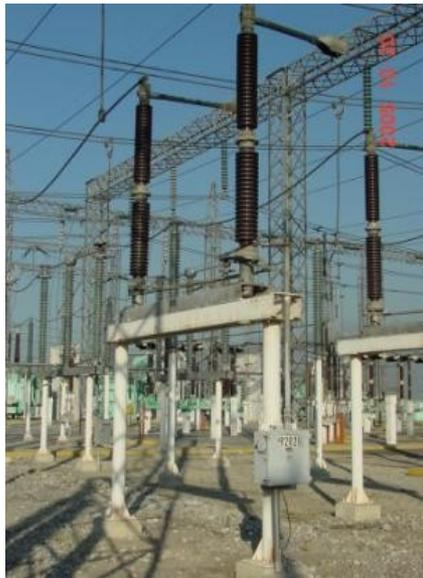
CUCHILLA TIPO OPERACIÓN HORIZONTAL 230 KV.
