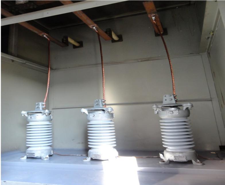
APARTARRAYOS DENTRO DE UN TABLERO METAL CLAD PARA 23KV.
