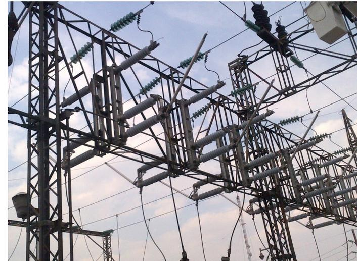
CUCHILLAS DE OPERACIÓN EN GRUPO DE APERTURA VERTICAL, MONTAJE VERTICAL EN 85 KV.
