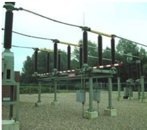
*Seccionadores de columnas giratorias.*
