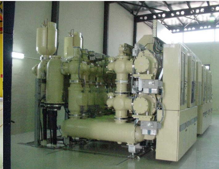
**GIS SIEMENS 220 kV. Aislamiento trifásico
