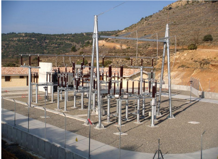
Subestación Intemperie
