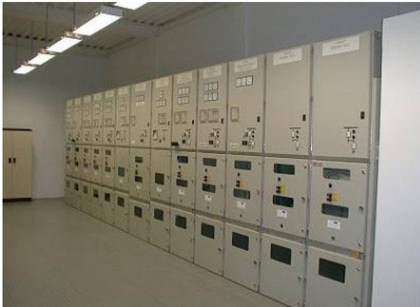
Subestación tipo interior metálicos blindados (Metal-Clad)
