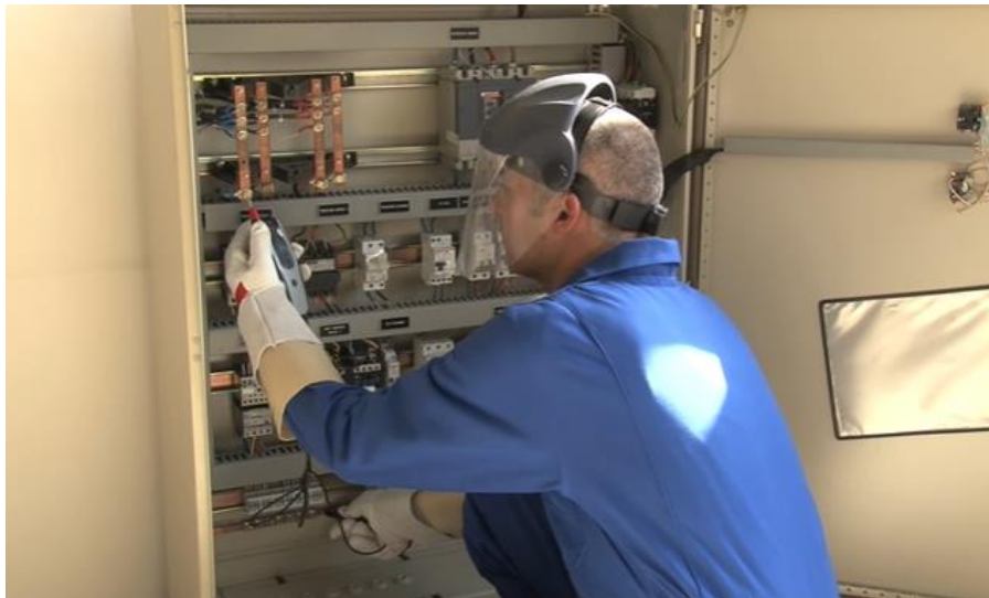
Verificar la ausencia de tensión en las líneas
