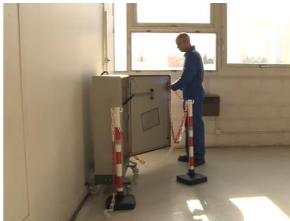
Delimitar y señalizar la zona de trabajo
