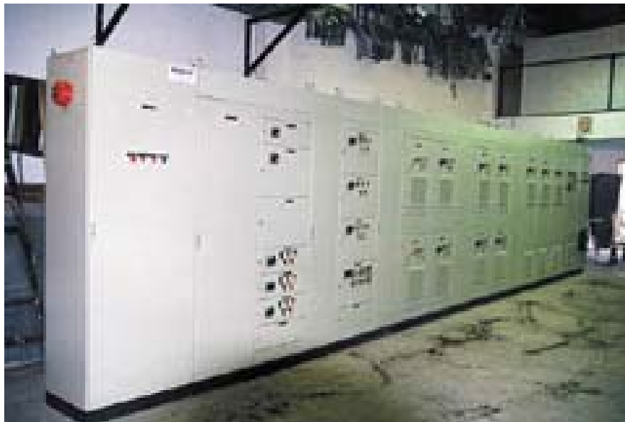
Figura 7.8 Tablero eléctrico para instalación interior.
