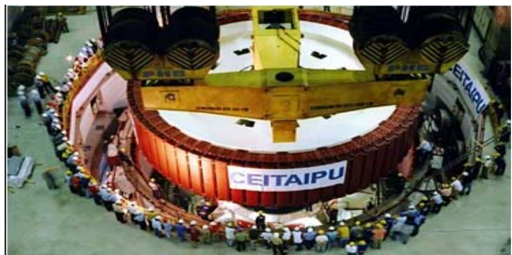
Figura 1.3 Rotor de generador (central hidroeléctrica de Itaipu).
