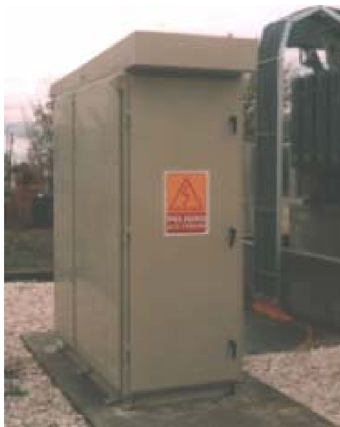
Figura 7.9 Tablero eléctrico para instalación exterior.
