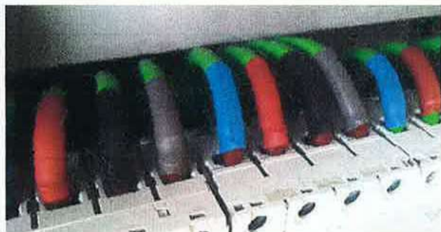
Figura 2.13. Marcado manual del cableado en base al código de colores.
