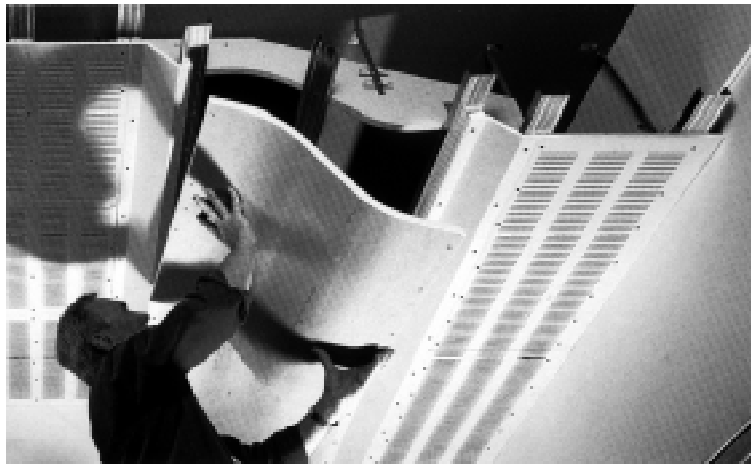
Colocación de una placa Knauff para formar un falso techo acústico continuo.
