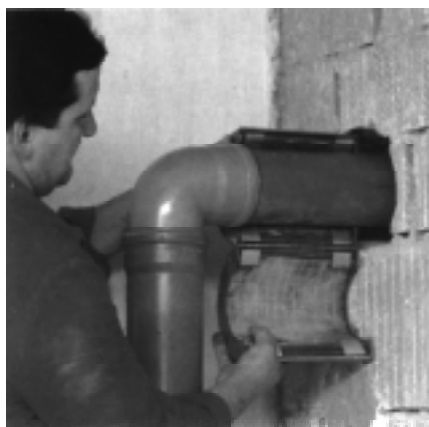
Productos intumescentes paran impedir la propagación del fuego a través de los pasos de las instalaciones (Intumex).
