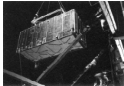
Módulo prefabricado de aseos en el banco de Honkong.
