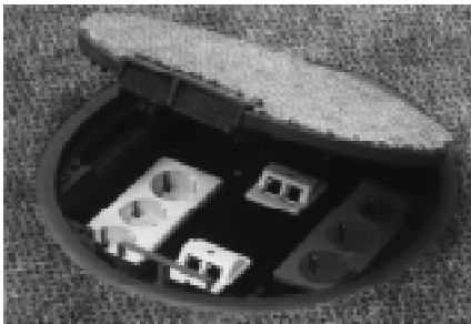
Acceso a unas cajas de pavimento con conexiones eléctricas.
