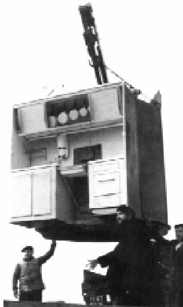
Los núcleos prefabricados de baño y cocina para las viviendas del Abbé Pierre, 1956 (J. Prouvé).
