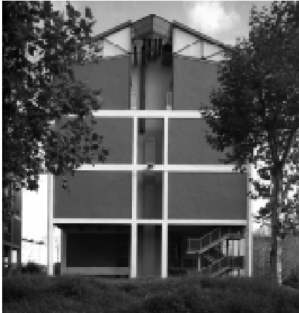
Patio abierto a fachada en el edificio de servicios Schlumberger, Montrouge, París, 1981-84 (R. Piano).
