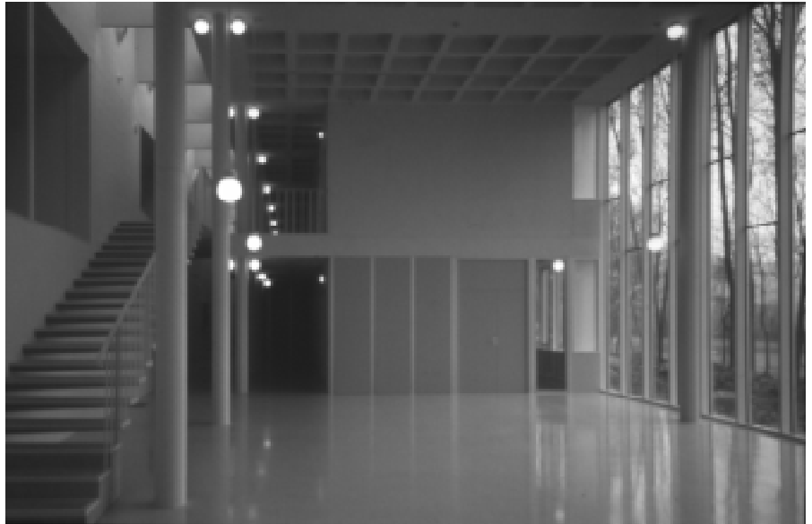
Coordinación de maineles, mamparas y techo reticular en las oficinas de la fábrica Simón, Olot, Girona, 1999 (Ll. Clotet, I. Paricio).
