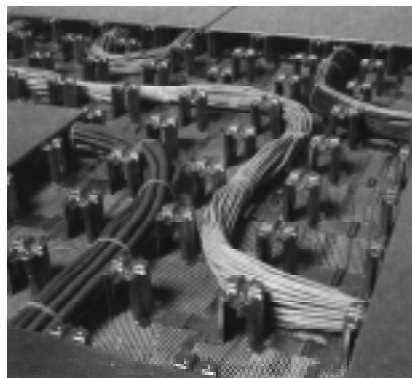
El suelo técnico Intercell de patente norteamericana.
