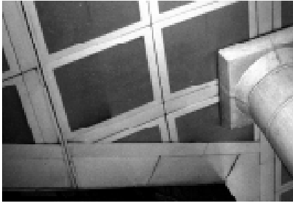
Cielo raso en el aeropuerto de Barcelona.
