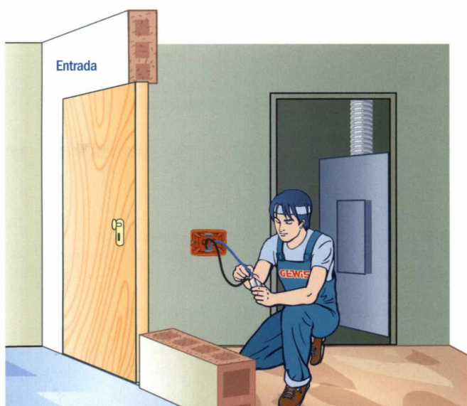
3. Conexión del termostato ambiente con el cuarto de caldera exterior a la vivienda
