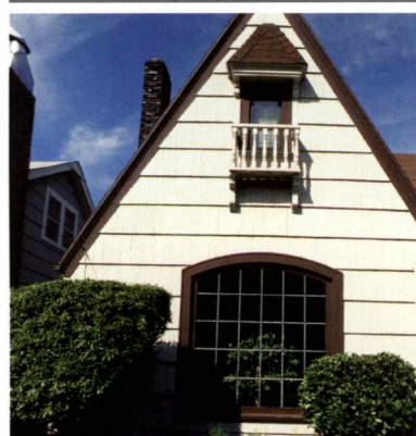
Chalet de 2 plantas Varías habitaciones + doble/triple servicios Más de 160 m 2 Consumo de potencia 9,2 kW (máximo) Calefacción individual con cuarto de caldera Instalación de tipo lujo
