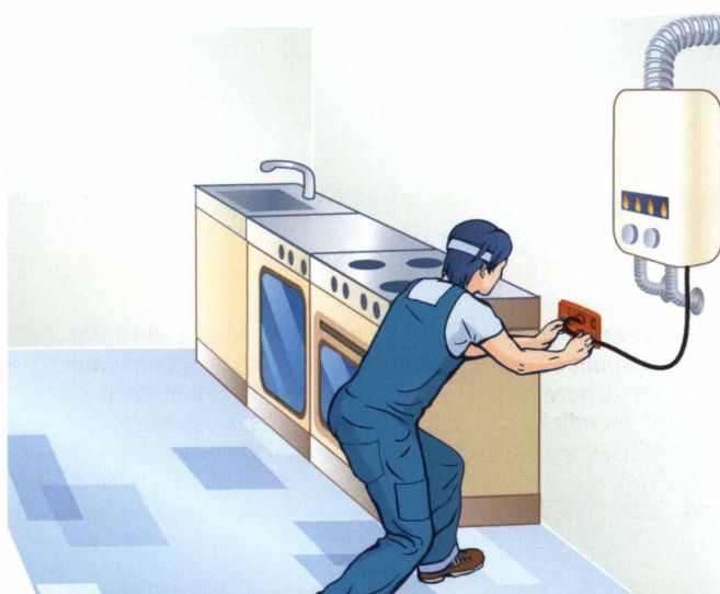
4. Conexión del termostato ambiente situado a la entrada de la caldera en cocina
