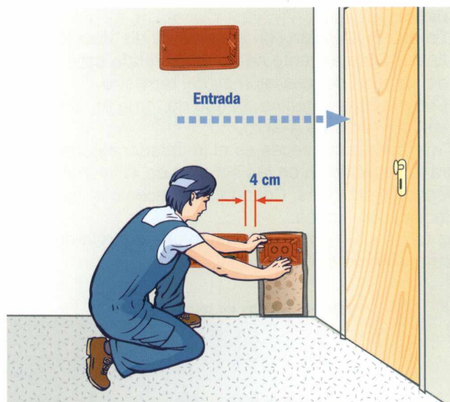
2. Ejemplo de albañilería de caja de derivación para llegada de líneas telefónicas
