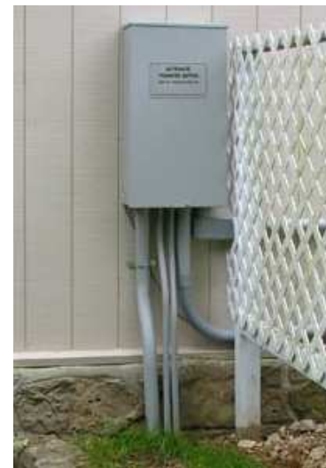
Detalle de la línea de acometida y la Caja General de Protección.
