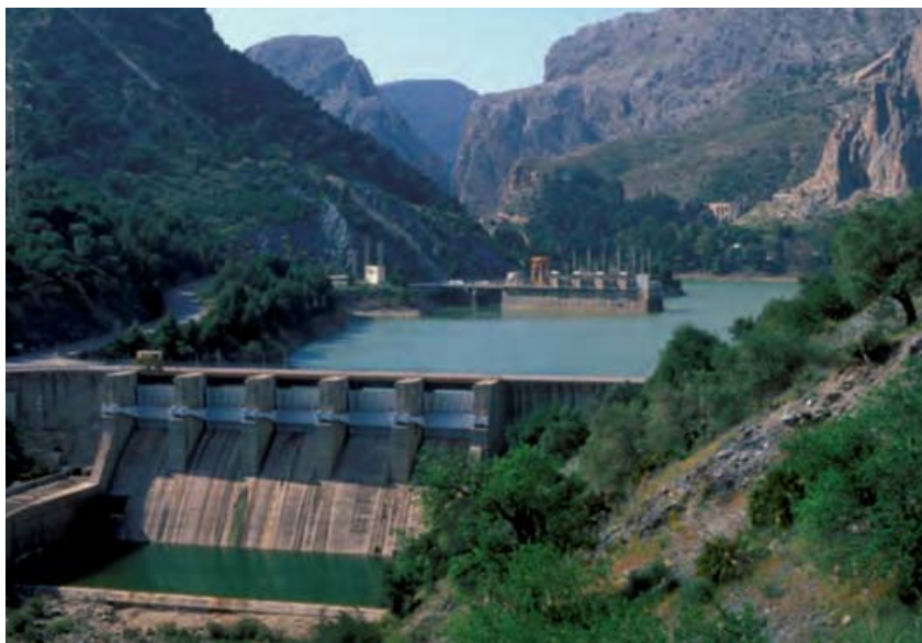
Foto 5.1. Central hidroeléctrica. Fuente: Endesa.
