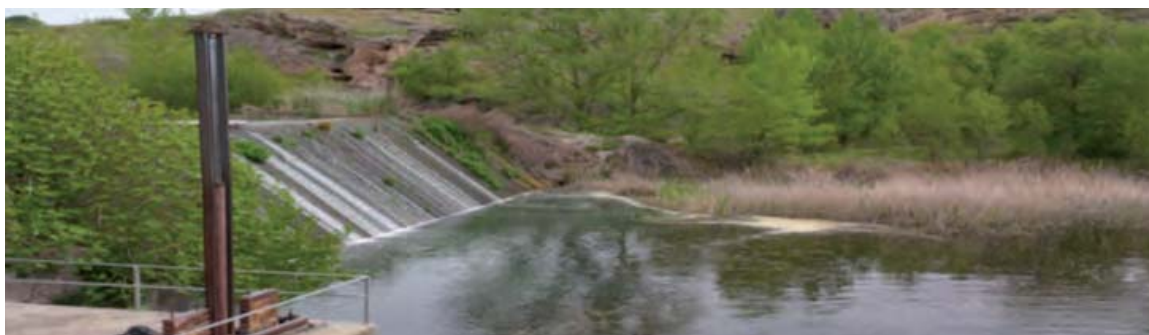
Foto 1.3. Central hidroeléctrica de Estremera.
