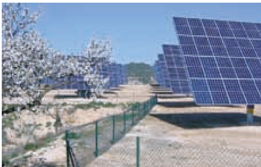
Foto 5. Agrupación de instalaciones fotovoltaicas.
