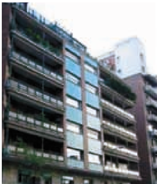
Foto 6. Edificios de viviendas con caldera de biomasa para calefacción.
