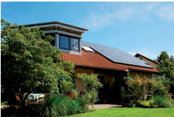
Fig. 1: Los módulos solares convierten la energía solar en electricidad
