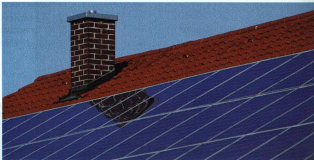
↑ Figura 5.2. Sistema fotovoltaico instalado en el tejado de una vivienda.
