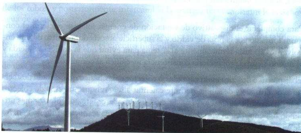
← Figura 6.12. Parque eólico de Sofuentes.
