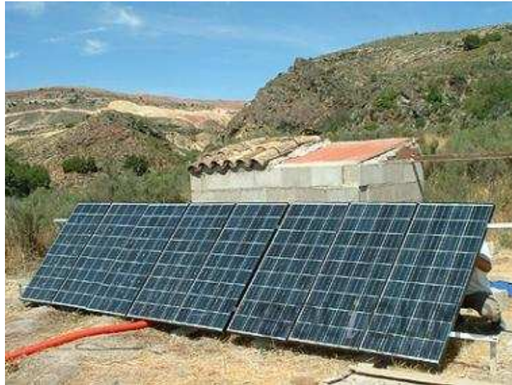
Ilustración de un generador solar fotovoltaico sobre suelo conectado a red (Fuente: www.soliclima.es )
