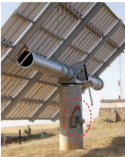
Fig. 1.17. Caja de conexiones de un módulo fotovoltaico.
