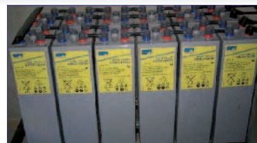
Fig. 1.24. Baterías de GEL. Vastos de 2 V.
