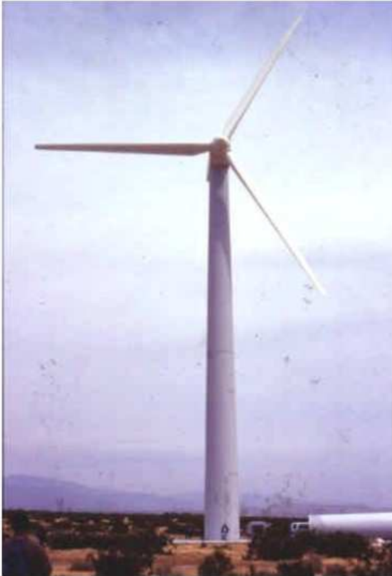
Figura 13. Turbina de eje horizontal
