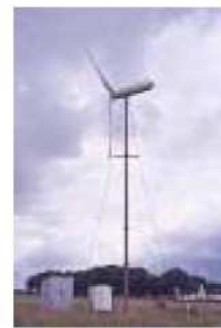
Torre sostenida por cables
