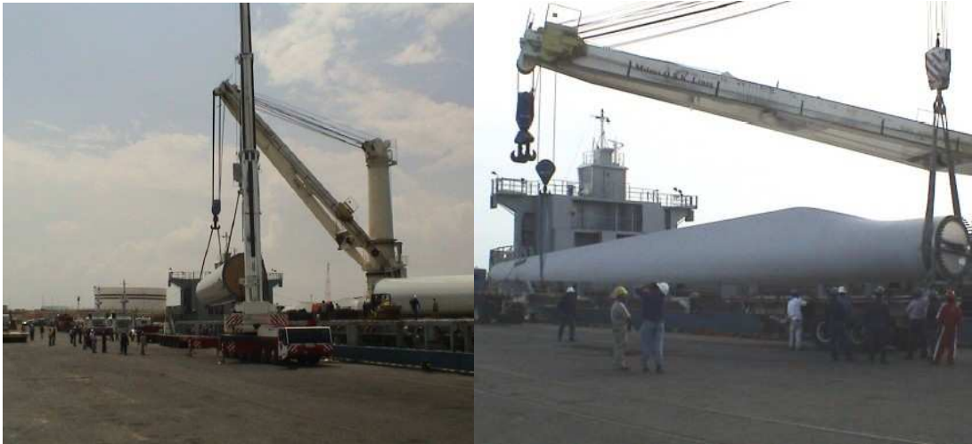
Figura 48. Descarga de una sección de la torre y de una de las palas de los aerogeneradores N60/1300 KW, del parque Eólico Jepirachi.
