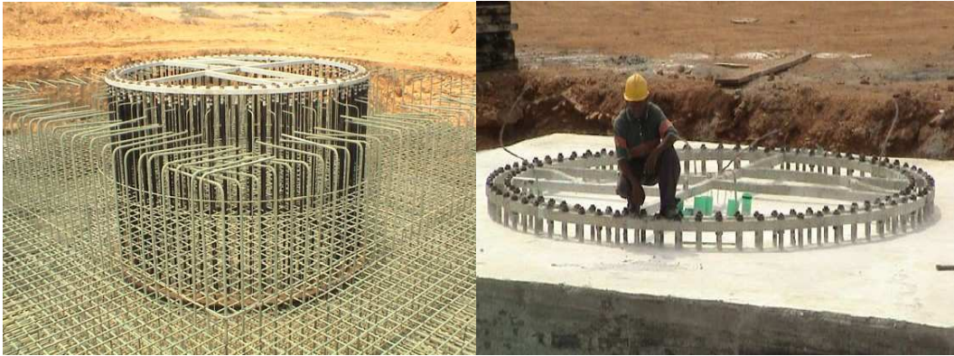
Figura 47. Virola de pernos para la torre de un aerogenerador rodeado por la malla de tierra y el enmallado de la base de la obra civil antes y después de vaciado el concreto en el Parque Eólico Jepirachi.
