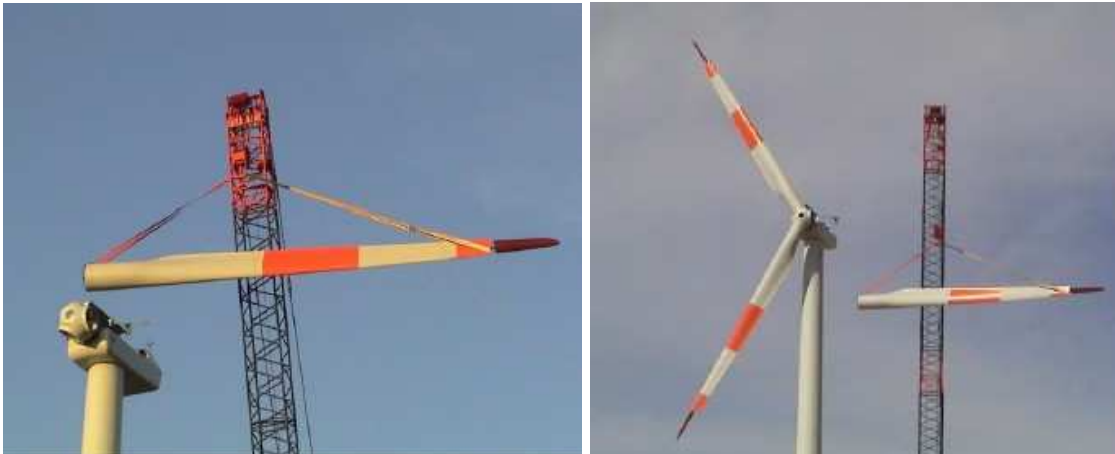
Figura 49. Izado de la primera y tercera pala del aerogenerador Nordex N60/1300 KW
