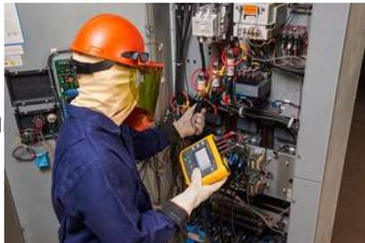
Nota: la flecha que aparece en la parte interior de la sonda flexible debería apuntar hacia la carga que se está analizando para asegurar unas lecturas correctas
