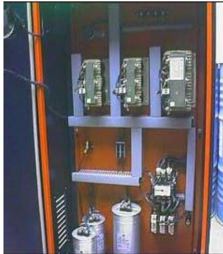
FIG REPRESENTACION DE UN FILTRO SINTONIZADO AUTOMATICO.
