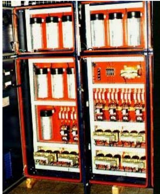
FIGURA VII.9 FILTRO ANTIRRESONANTE AUTOMÁTICO.
