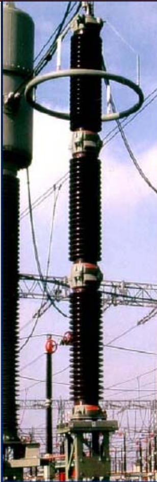
Envolvente en porcelana. 800kV
